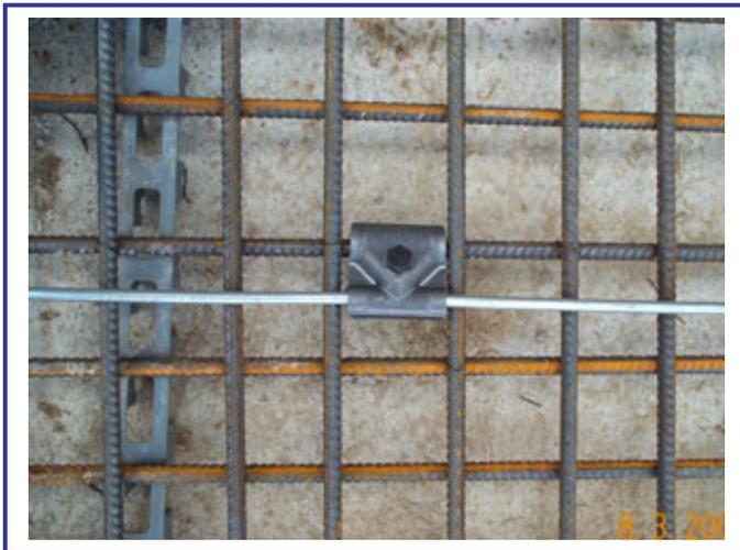
Bild 4: Kontaktierung der Bewehrung mit Klemme 308 041
