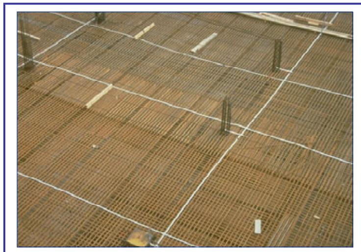
Bild 1: Fundamenterder als Masche in bewehrten Beton
